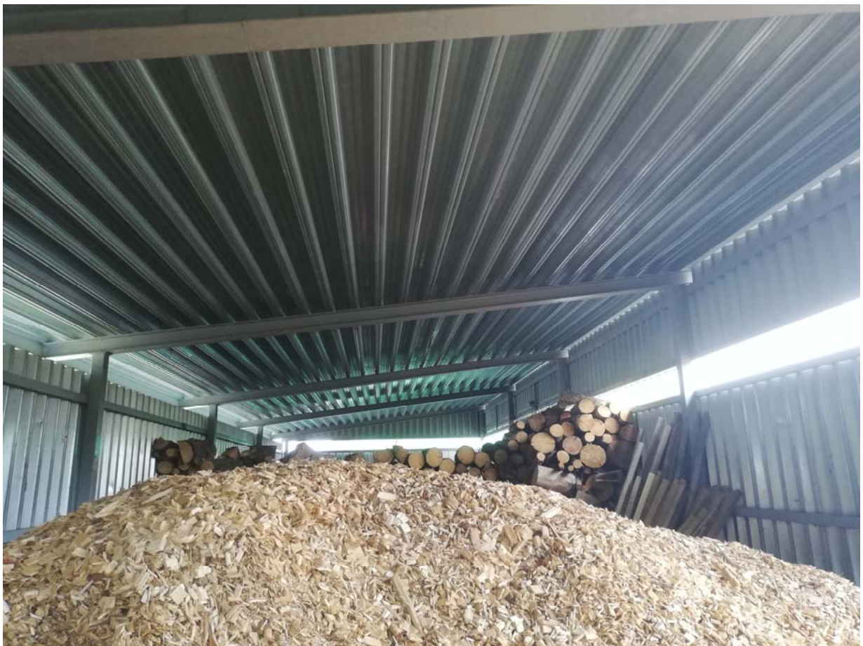
06 pav. Nagrinėjamo statinio stogo konstrukcijų fotofiksacija
