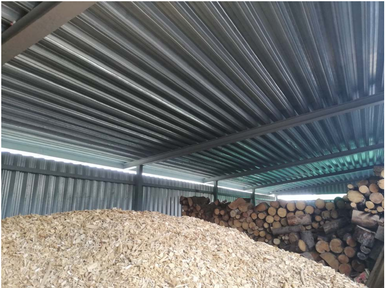
05 pav. Nagrinėjamo statinio stogo konstrukcijų fotofiksacija
