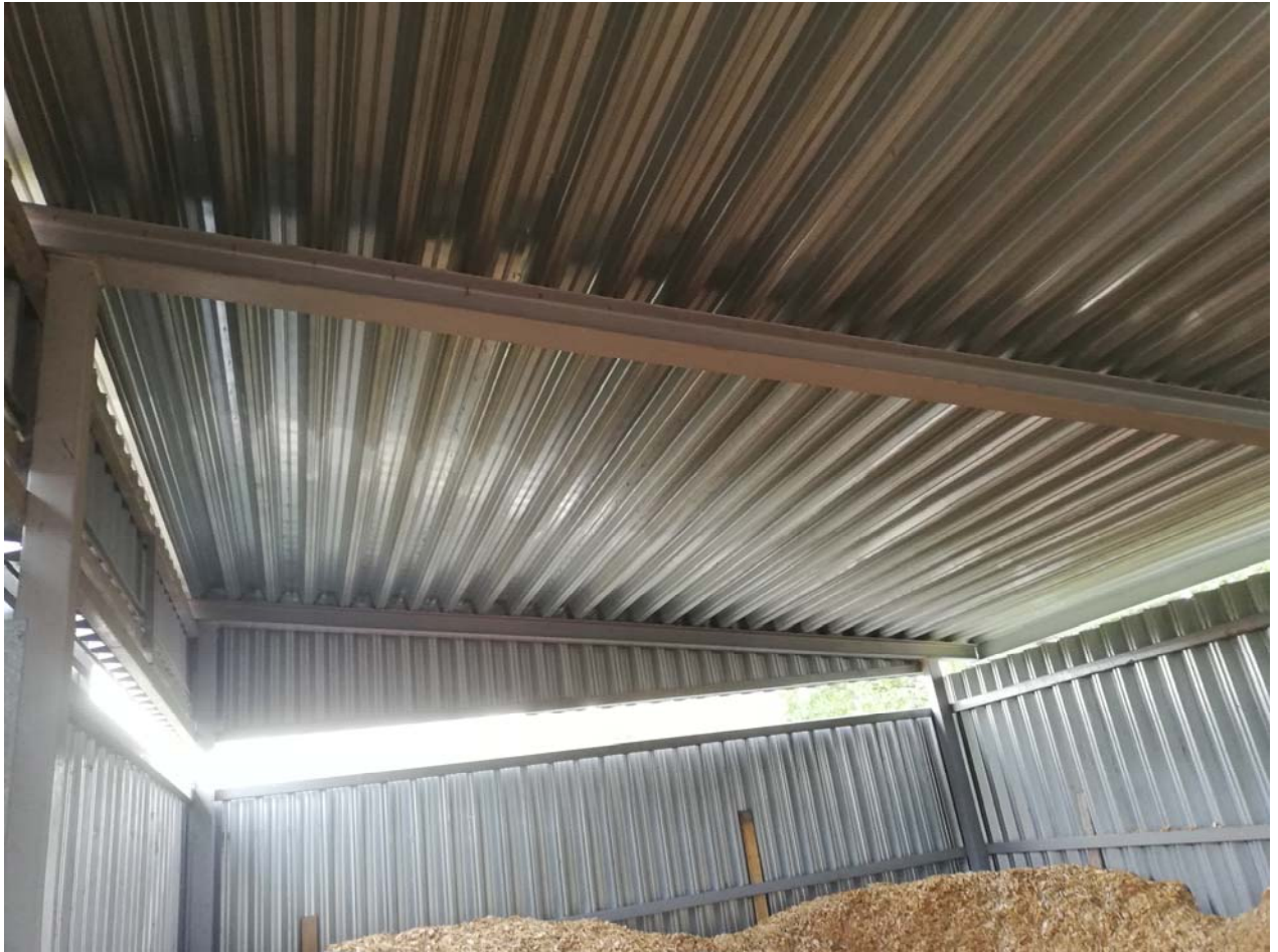
03 pav. Nagrinėjamo statinio stogo konstrukcijų fotografacija
