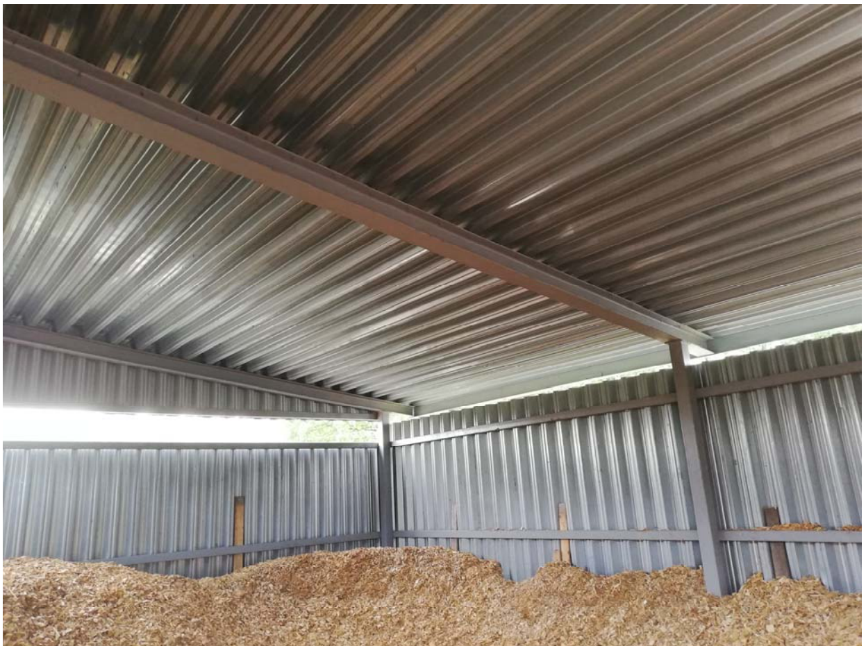
04 pav. Nagrinėjamo statinio stogo konstrukcijų fotografacija
